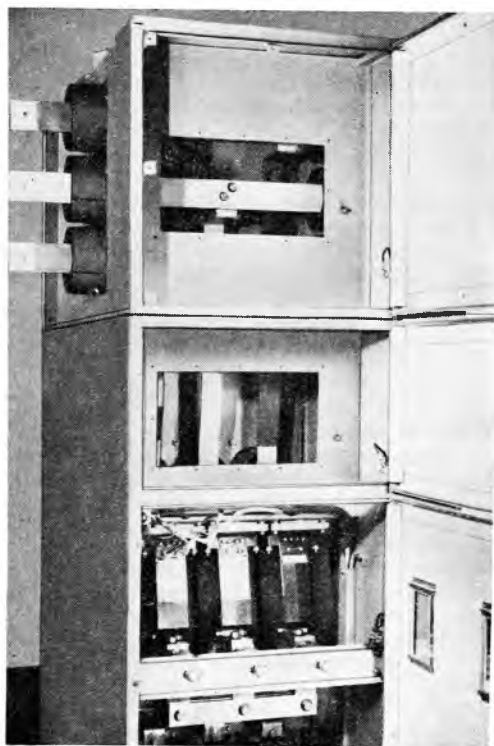
34-7. ábra. NT 12 kapcsolóberendezés nyitott helyzetben
